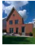
Achtergevel F1 en F2
